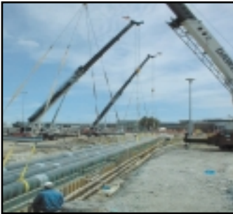
Box Conduit & Pipe Setting
